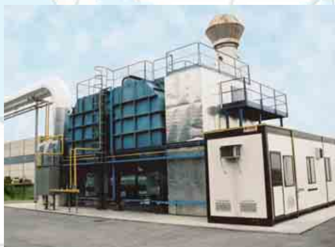
Druk litograficzny na metalu • Strumień gazów: 36.000 \text{Nm}^3/\text{h}
