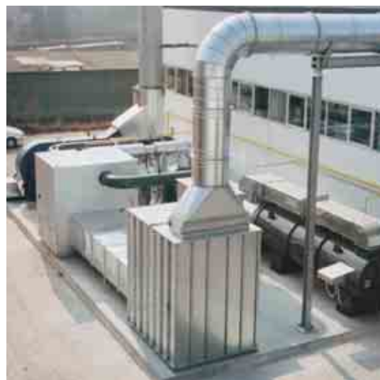
Produkcja farb Strumień gazów: 70.000 Nm 3 /h
