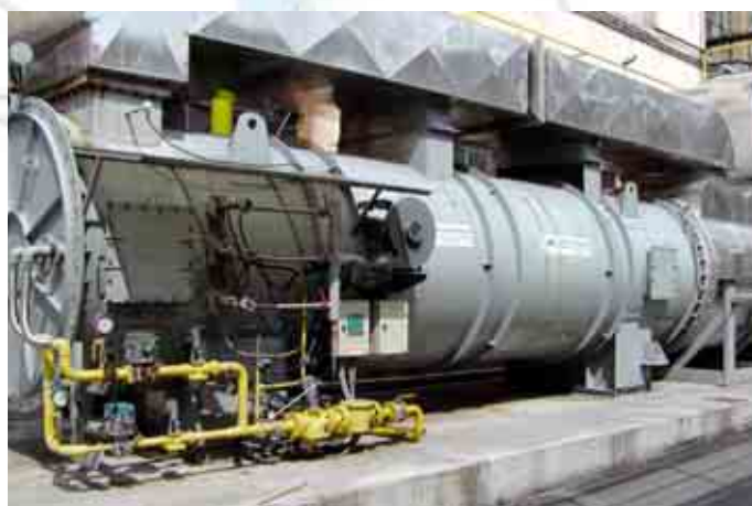
Druk rotograviurowy • 20.000 Nm 3 /h
