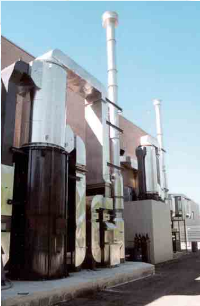
Farmacja • Bliźniacze dopalacze z podgrzewem wody i powietrza. Strumień gazów 6.000 Nm 3 /h
