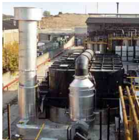
Fabryka włókien sztucznych • Strumień gazów: 50.000 Nm 3 /h • Odzysk ciepła w oleju termalnym
