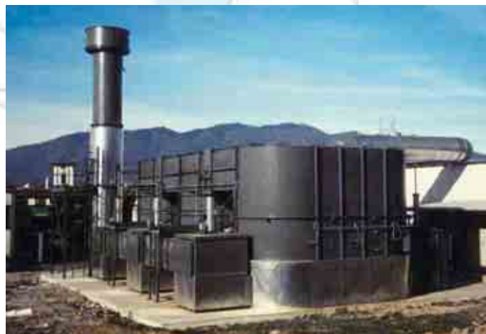
Druk rotograviurowy Strumień gazów: 40.000 Nm 3 /h
