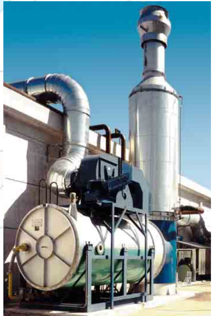
Garbarnia • Strumień gazów 20.000 Nm 3 /h • Odzysk ciepła w oleju termalnym
