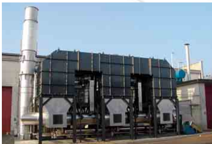
Produkcja taśm samoprzylepnych Strumień gazów: 13.000 Nm 3 /h
