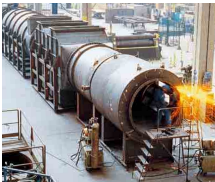
Fabryka Babcock Wanson we Włoszech Konstrukcja dopalacza odzyskowego na 45.000 Nm 3 /h
